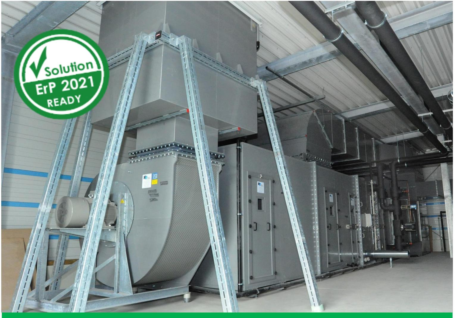
Les CTA plastiques LPA / HLU sont spécialement conçues pour l'extraction d'air vicié ainsi que les gaz humides et corrosifs, y compris en zone Atex 1 et 2.
